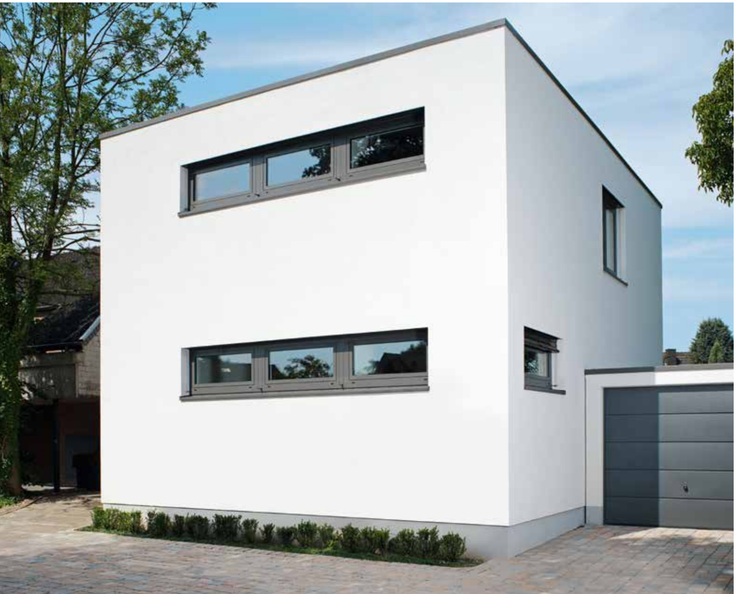
Fenster sind dominante Gestaltungselemente.
