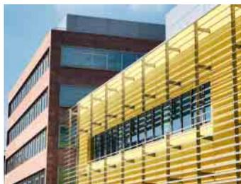
Schüco Großlamellen ALB-starr sind die Komplettlösung für umfassenden Sonnenschutz. Die Lamellen können horizontal, vertikal sowie auskragend angeordnet werden. Die Vorteile reichen vom Schutz vor Überhitzung über optimierten Lichteinfall bis hin zu erhöhtem Komfort.
